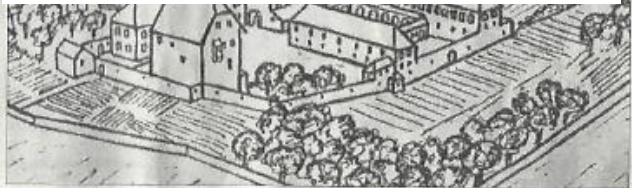
Diese Zeichnung des Münsters, die als Grundlage für das Modell dienen soll, hat Christoph Haag 1933 gefertigt. Vor der Zerstörung im Bauernkrieg im Jahr 1525 gab es noch einen Chorumgang. Repro: Anita Dlugob
